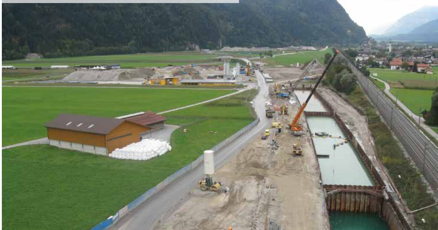
Временная траншея, железная дорога в Бреннер, Австрия
