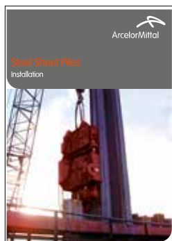
Погружение шпунтовых свай GB, DE, FR
