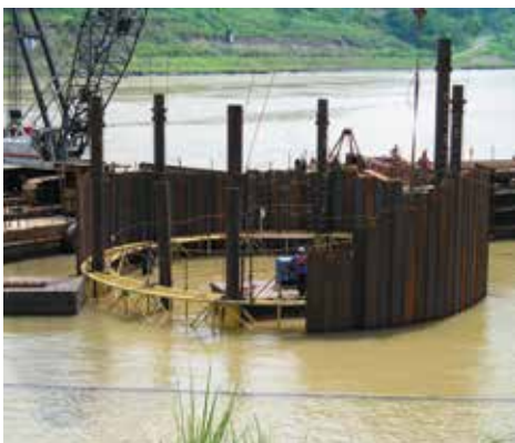
2. Установка свай до замыкания ячейки
