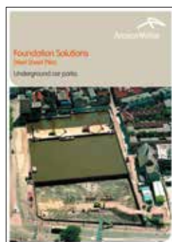
Подземные автостоянки GB, PT
