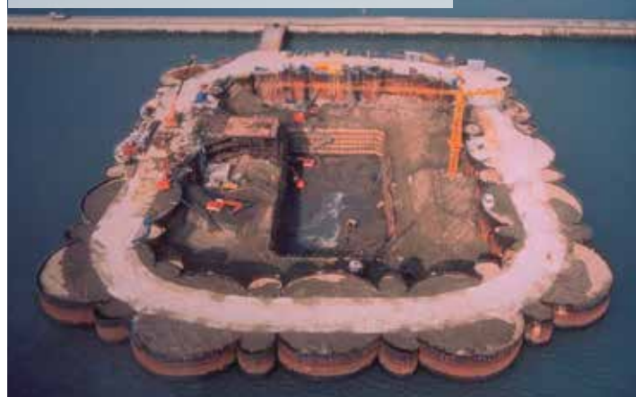
Строительство моста, Южная Корея
