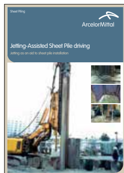
Погружение свай под давлением GB, DE, FR
